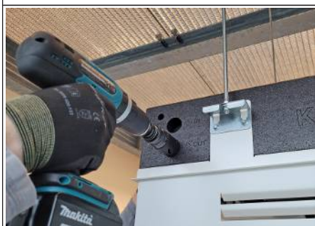
Fig. 16: Apertura fori di attacco
