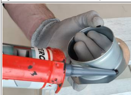
Fig. 24: Sigillatura bocchettoni di attacco aria primaria
