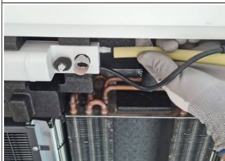
Fig. 21: Fissaggio del tubo flessibile condensa sulla pompa condensa
