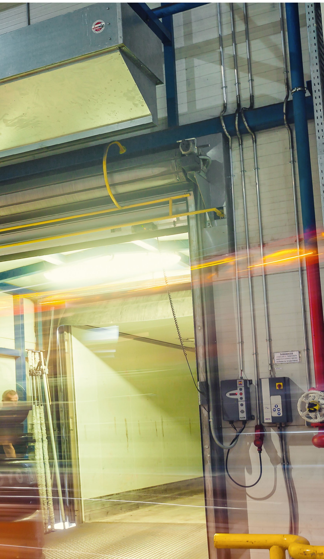
Le barriere d'aria ProtecTor contrastano l'entrata di aria fredda nell'area di carico della filiale Heineken "Volga", Nizhniy Novgorod, nel cuore della Russia.
